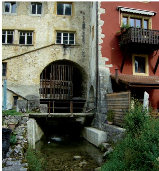
Um die „Rue du Stand“ dem Trennsystem anzuschliessen, benötigte es eine **Bohrung des Blocksteingewölbes der Sorge, unter der Kantonstrasse**, um das saubere Wasser in den Bach einleiten zu können.
