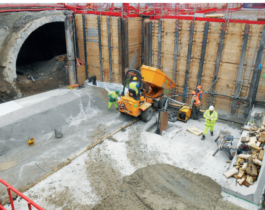
Le CEVA, un chantier complexe au cœur de Genève.
